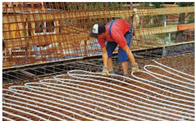
Rohrregister zur thermischen Aktivierung von Betondecken
