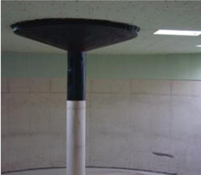
Bild 6: Beschichtung und Wärmedämmung im Fermentergasraum
