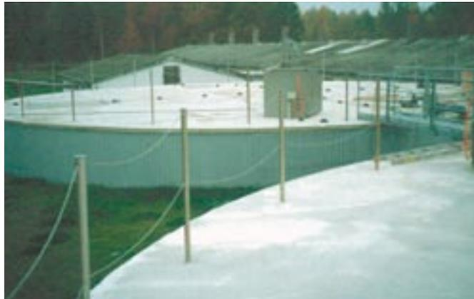
Bild 3: Biogasfermenter mit Betondecke
