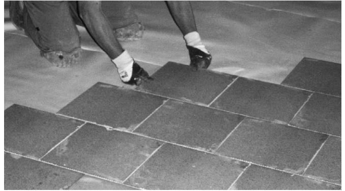
Bild 9: Fertigteilestrich aus zementgebundenen Platten
