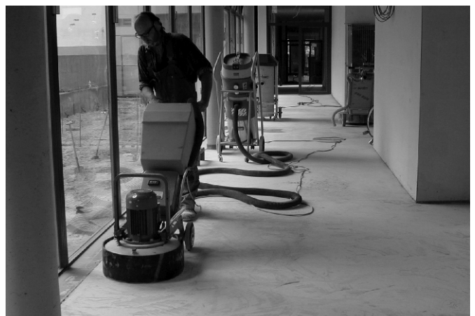
Bild 10: Anschleifen eines Zementestrichs
