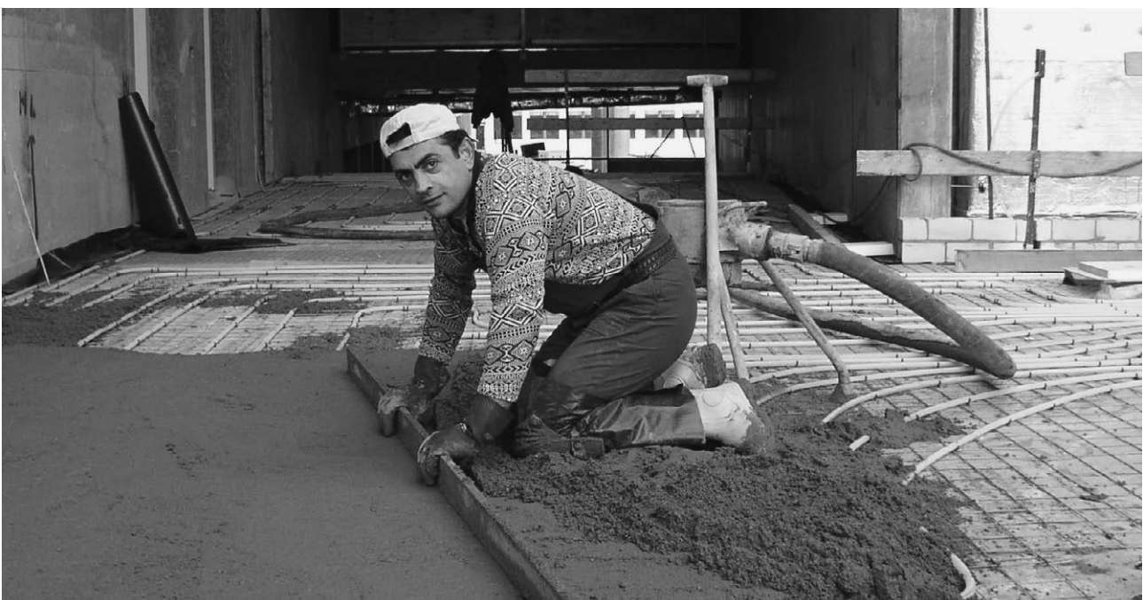
Bild 1: Estricheinbau
