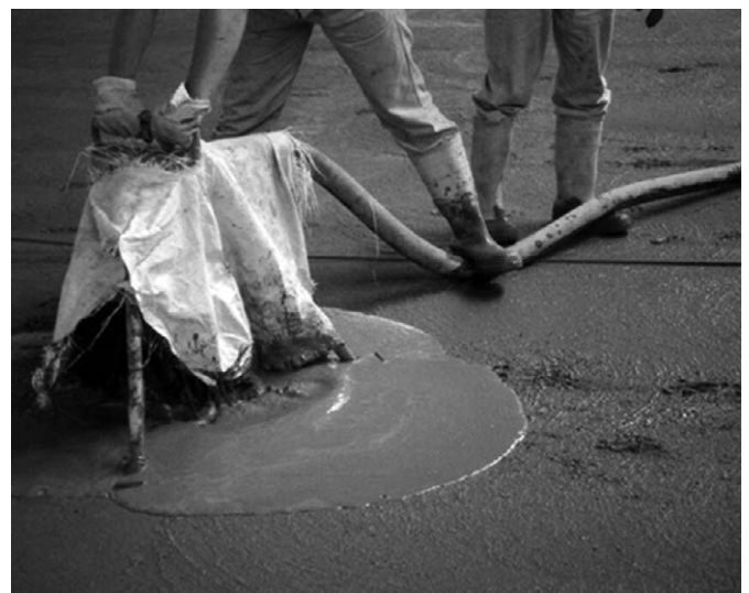
Bild 8: Ausbringen des Hartstoffestrichs frisch in frisch
